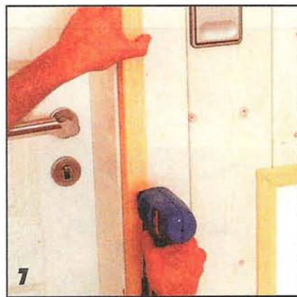
Обшитые вагонкой поверхности стен обрамляют покрытыми лазурью уголками, прибивая их к доскам обшивки мелкими отделочными гвоздями.
