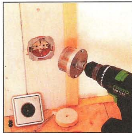
Отверстия под розетки вырезают кольцевой пилой.
