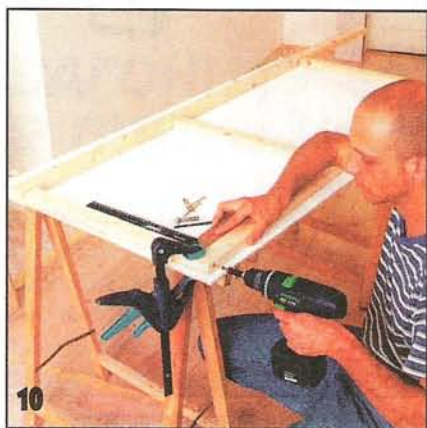
10 Раму для дверки ниши собирают из строганных реек. Позже дверку навешивают на откидных петлях.
