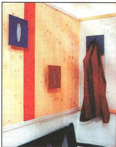
На дополнительных рейках обрешётки надёжно закреплены три элегантные настенные вешалки.
