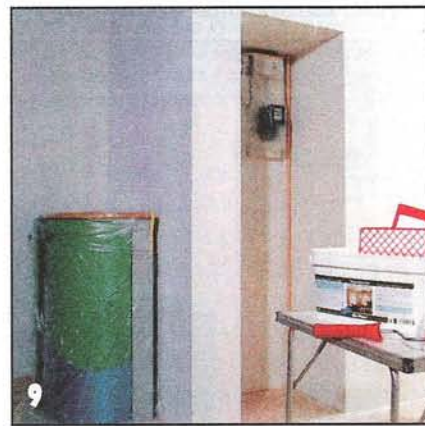
Обустройству подлежит и ниша, где расположен электрощиток. Её оклеивают обоями и красят.
