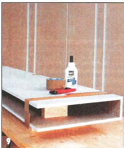
П-образные оболочки каркасов делают из гипсокартонных листов, сгибая их по двум параллельным V-образным пазам. Мерными прокладками при склейке служат отрезки деревянного бруска.
