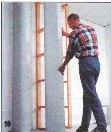
П-образные оболочки из гипсокартона осторожно надвигают на деревянные каркасы. Швы примыкания к стене шпательюют позже.
