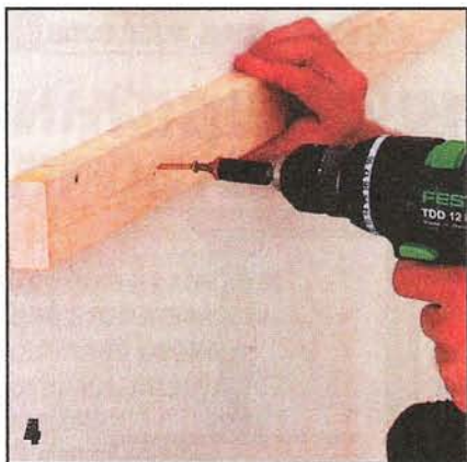
В дюбели сквозь отверстия в рейках обрешётки ввинчивают шурупы с потайной головкой.
