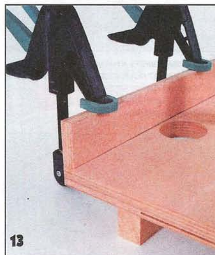
Отступив от передней кромки, сверлят отверстие для встроенного светильника. Затем приклеивают лицевую панель.
