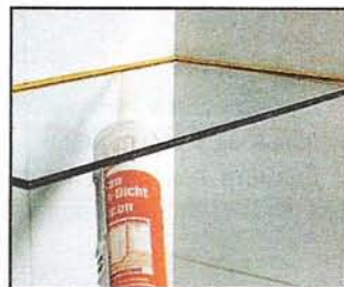
Нанеся в пазы профилей силиконовый герметик, в них вставляют стекла.
